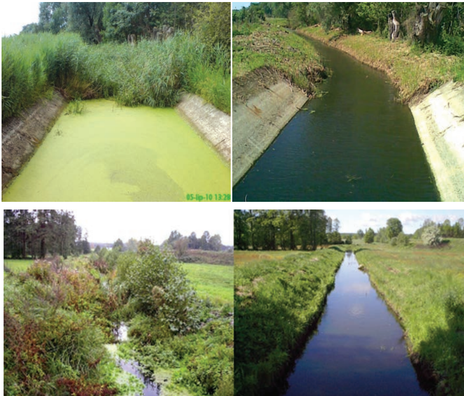
Ryc. 33. Stan kanału melioracyjnego przed i po konserwacji (fot. R. Marcinkowska 2010) (Przybyła i in. 2012)
