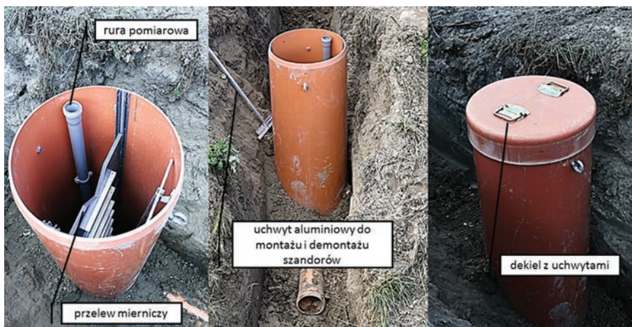
Ryc. 42. Montaż regulatora odpływu
