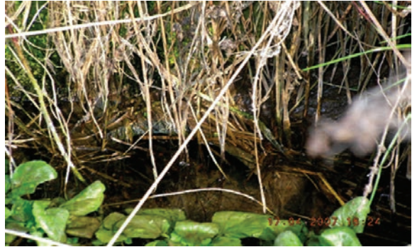
Ryc. 34. Przykład stanu wylotu drenarskiego (fot. A. Jarysz)
