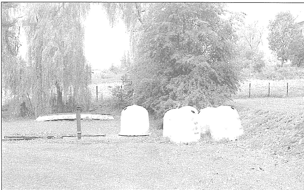
Ryc. 4. Obszar przewidziany pod budowę PSZOK dla Gminy Łądek (widoczne instalacja podziemne i naziemne do przełożenia)
