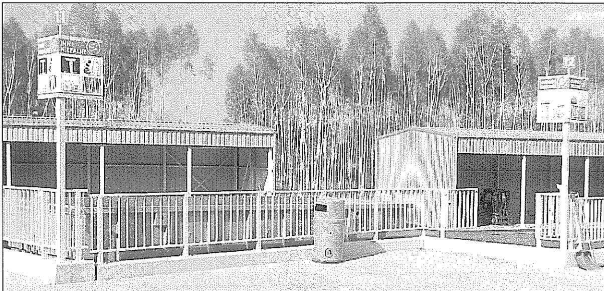
Ryc. 15 Przykład rampy rozładunkowej z barierkami i otwieranymi wrotami w miejscu lokalizacji kontenera na odpady (miejsce zrzutu) oraz oznakowanie kontenerów znajdujących się przy rampie rozładunkowej
